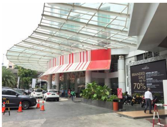
Gambar 34. Building Form 3 Sumber: Dokumentasi pribadi
