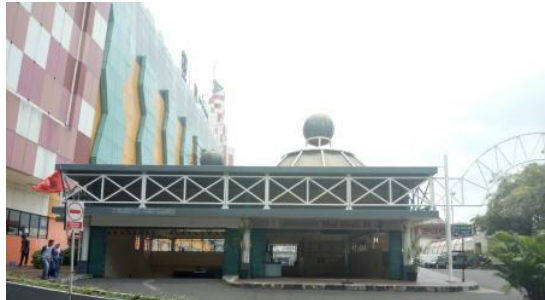
Gambar 32. Building Form 1 Sumber: Dokumentasi pribadi
