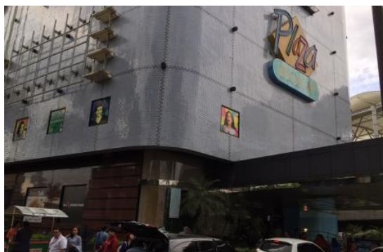
Gambar 33. Building Form 2 Sumber: Dokumentasi pribadi
